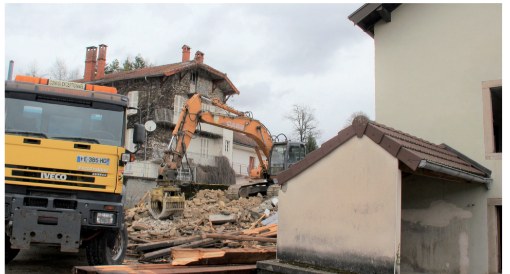
Travaux en cours
