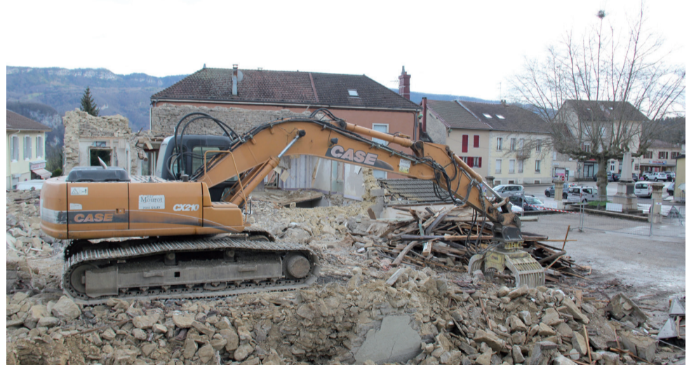
Démolition de la 2 e maison
