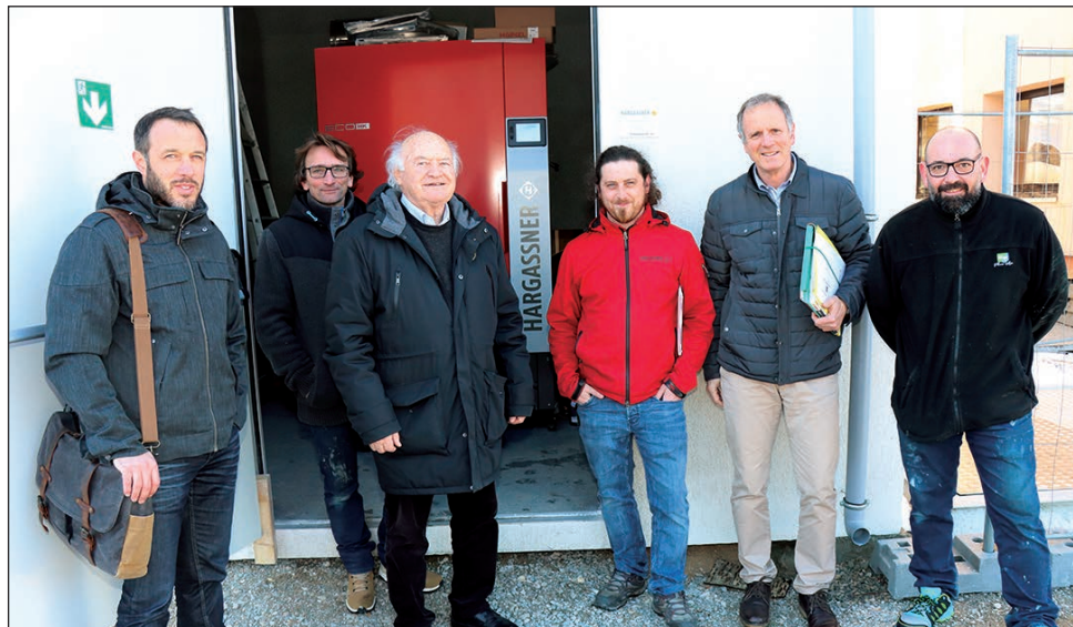
Devant la chaudière, Serge Poisnet entouré de l'équipe lors de la visite de chantier, tous satisfaits du résultat.
