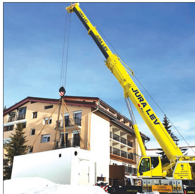
Installation des containers qui constitueront le silo.
