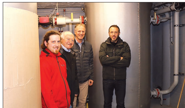
Devant les gros ballons d'eau chaude, en pleine explication du fonctionnement de la chaufferie.
