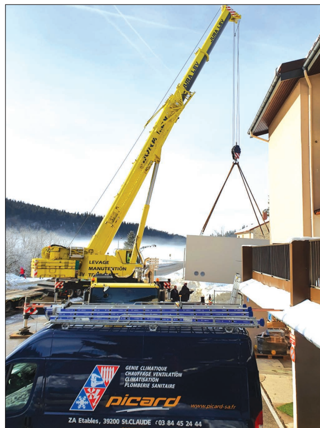
Installation des containers qui constitueront le silo.
