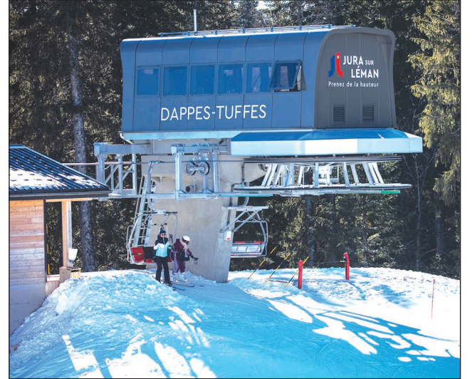
Le nouveau télésiège Dappes-Tuffes qui permet aux skieurs de relier sans effort les pistes suisses de la Dole avec le sommet des Tuffes, coté français.
