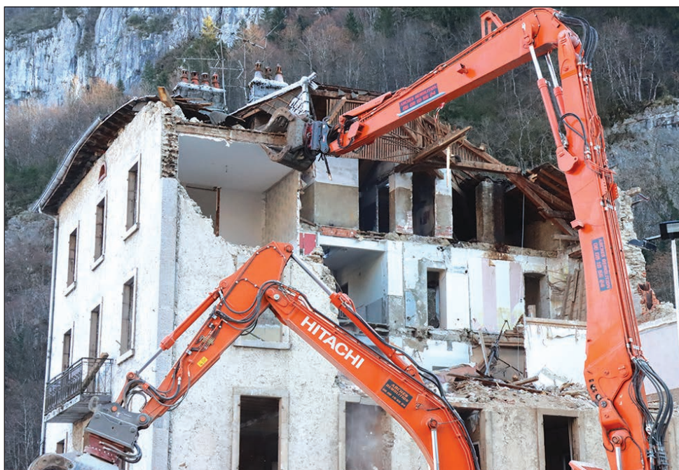
Spectaculaire démolition de la maison Perrier.
