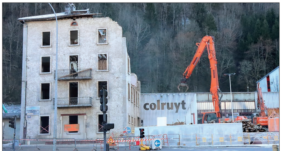
Lundi 17 janvier la démolition de la Maison Perrier et du magasin Colruyt a débuté.
